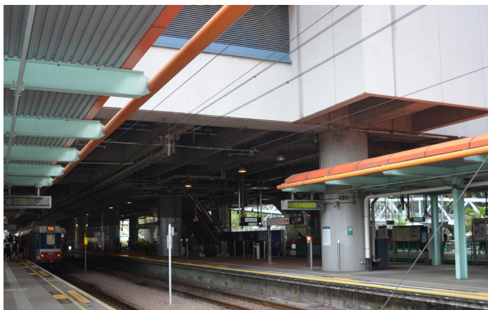
图 25：天水围轻便铁路站
