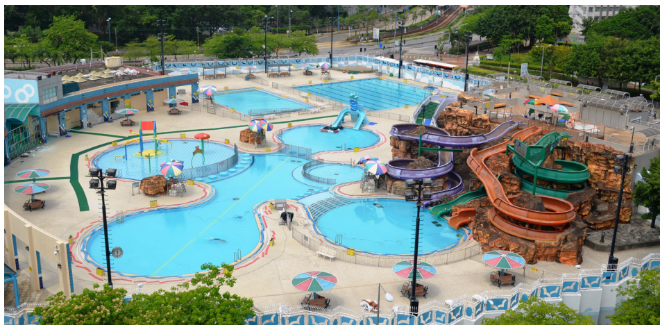
圖 19：天水圍游泳池
