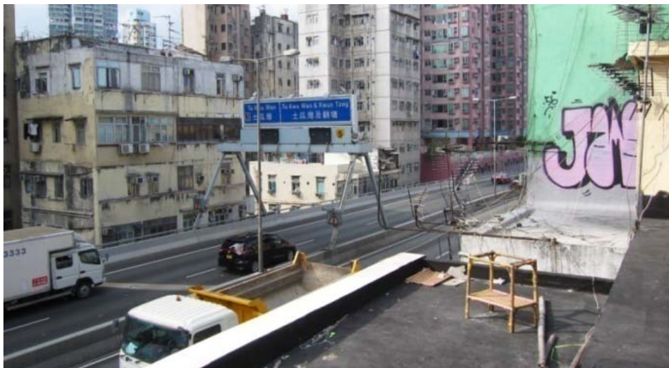
圖 18：東九龍走廊天橋與民居非常接近（近九龍城道一帶）
