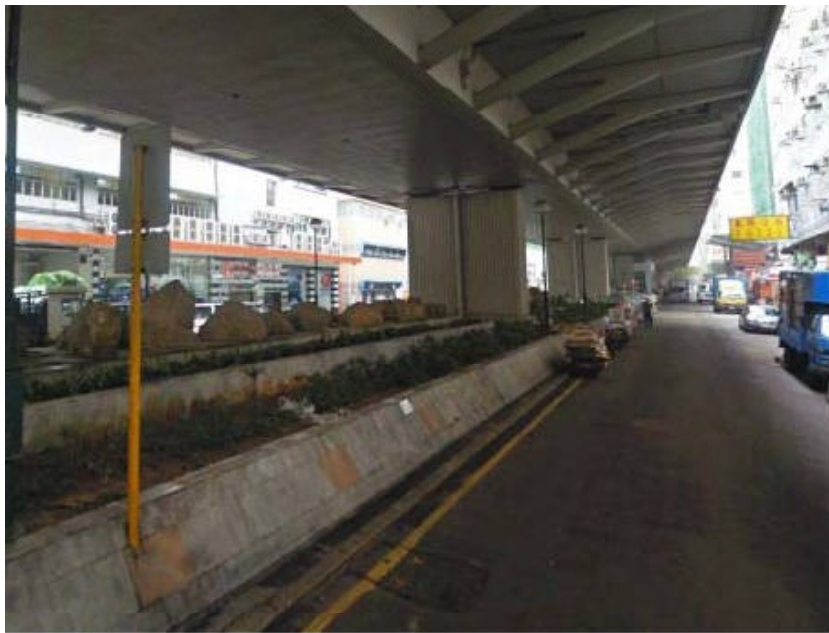
圖114：東九龍走廊天橋橋底部分空間現時佈置較為單調
