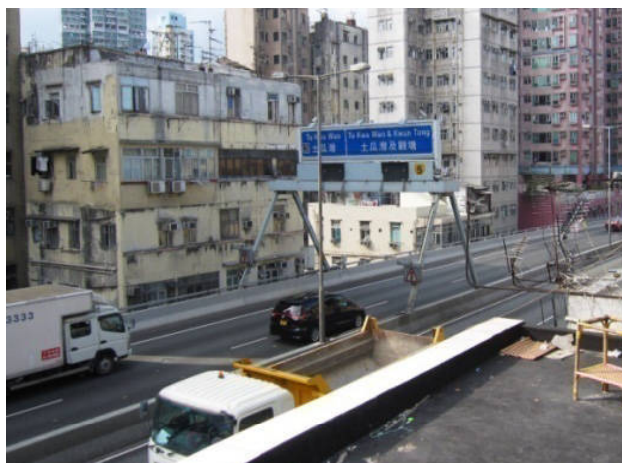
圖87：東九龍走廊天橋與民居非常接近（近九龍城道一帶）
