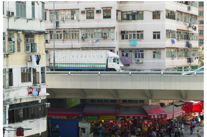
圖40：東九龍走廊位於九龍城道的天橋路段非常接近民居
