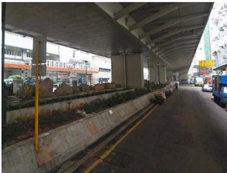
图114：东九龙走廊天桥桥底部分空间现时布置较为单调
