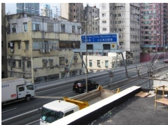
图87：东九龙走廊天桥与民居非常接近（近九龙城道一带）
