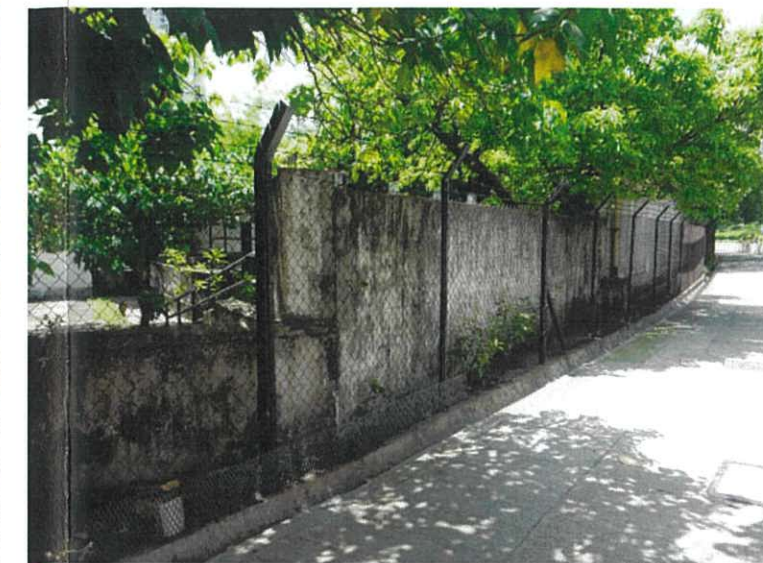
2 牛棚近啟德隧道出入口一帶被鐵網圍起
