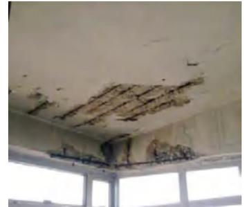
圖 II.19 五街、十三街樓宇失修的情況嚴重，有建築物的石屎剝落，鋼根外露
