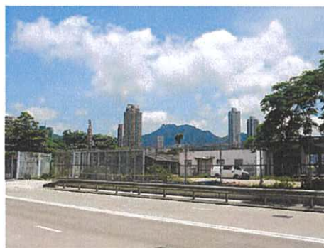
31: 獅子山山脊是九龍城區重要城市風貌
