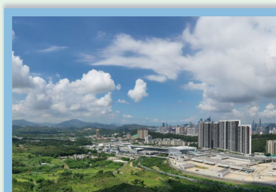
新界北餘下階段發展 - 新界北新市鎮及 文錦渡的規劃及工程研究 - 勘查研究
