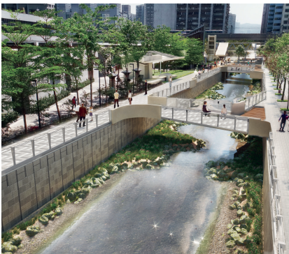
翠屏河活化工程 Tsui Ping River Revitalisation Project
