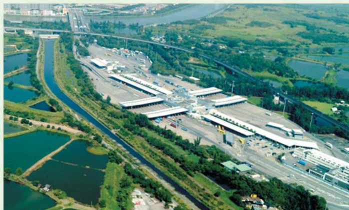
落馬洲邊境管制站
