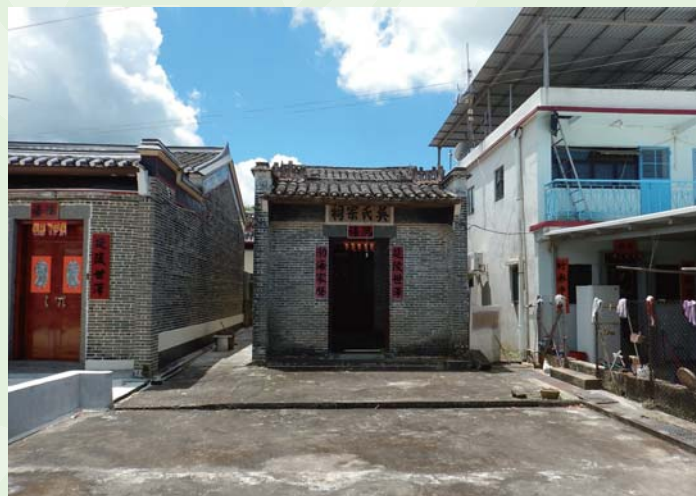
既有鄉村內的已獲評級建築物
